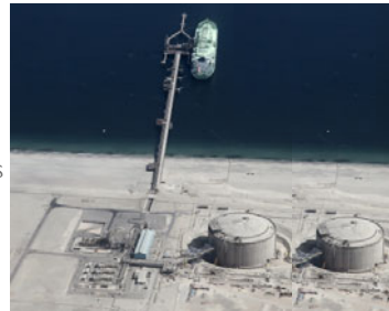
(nb. foto montaje para el segundo tanque a la derecha)
